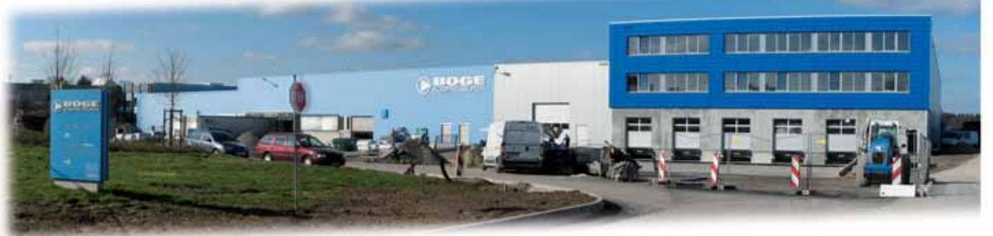
Der Neubau am BOGE-Stammsitz erweitert die Produktions- und Logistikfläche um 4.500 m 2 .
